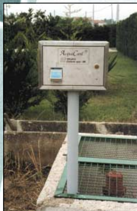
AcquaCard ® instalado para Equipo Hidráulico en arqueta
